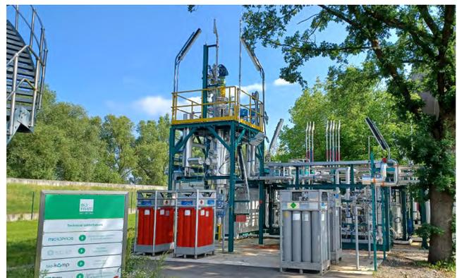
**Bild 7:** BioFARM neben den Faulbehältern der Kläranlage Straubing
