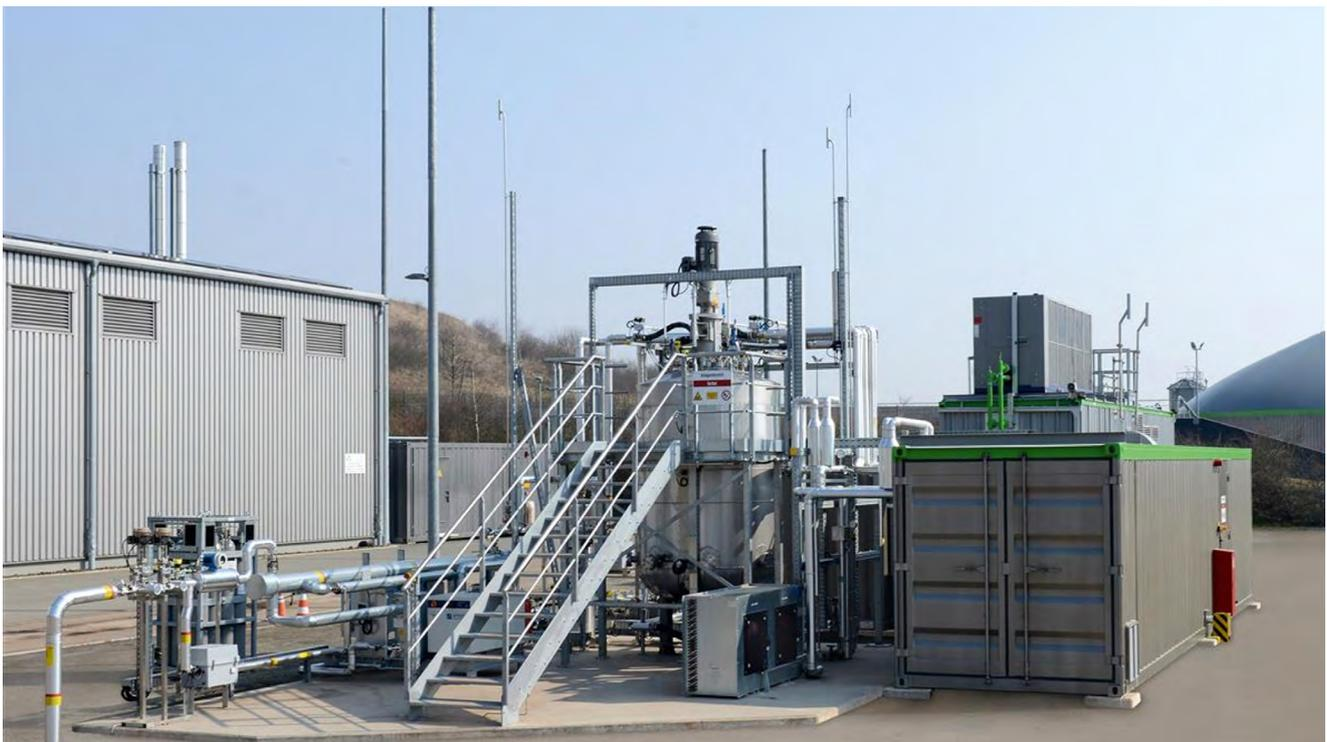
**Bild 6:** Anlage zur biologischen Methanisierung in Allendorf (Quelle: Kanadevia Inova Schmack GmbH)
